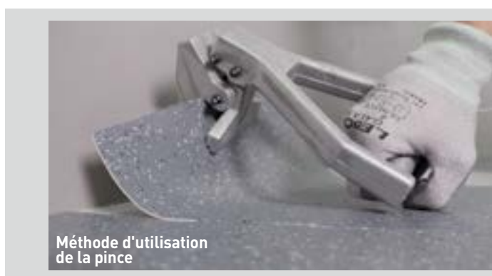
La pince facilite grandement l'opération de décollage
